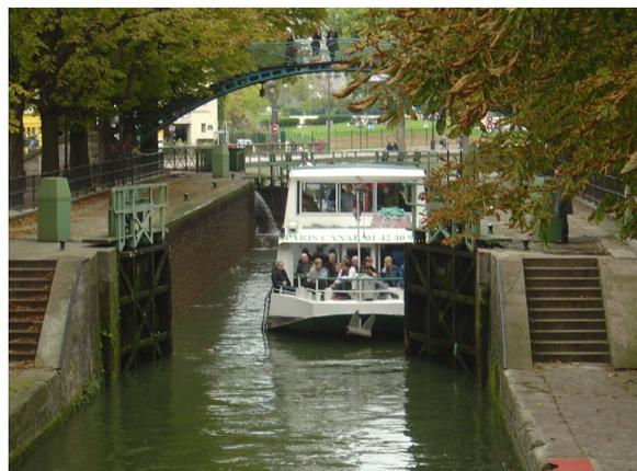
Fermeture de l'écluse à l'arrière, descente du niveau d'eau puis ouverture des portes avant et la péniche s'avance vers le pont tournant.( rue de la Grange-aux-Belles)
